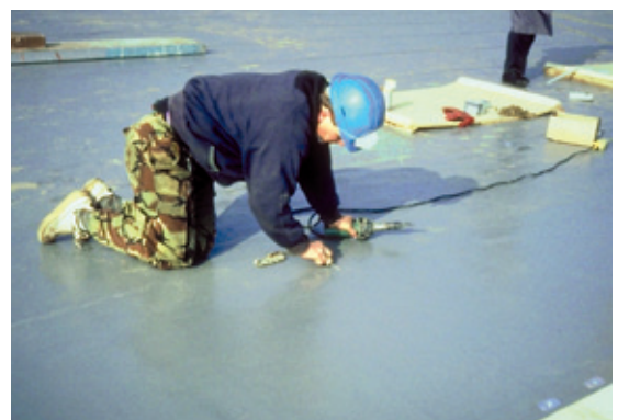
2 ábra: A hegesztési varrat ellenőrzése
