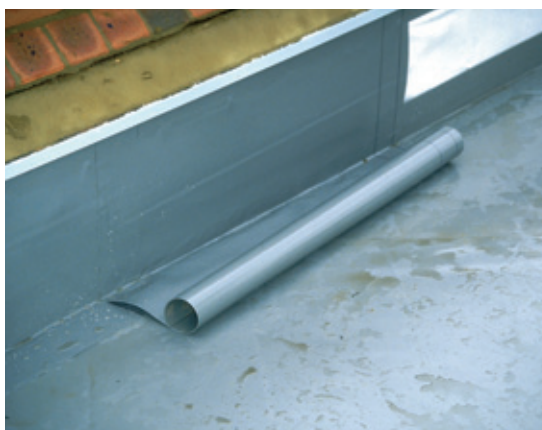
3 ábra: Szegélyrögzítés RENOLIT ALKORPLUS 81170 fóliabádoggal
