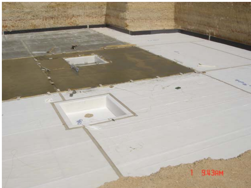
A védőbeton készítése
