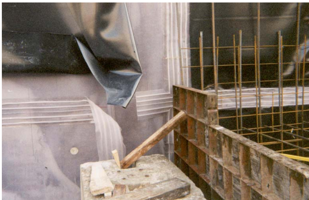
A vízszigetelő rendszer sérülésének veszélye
